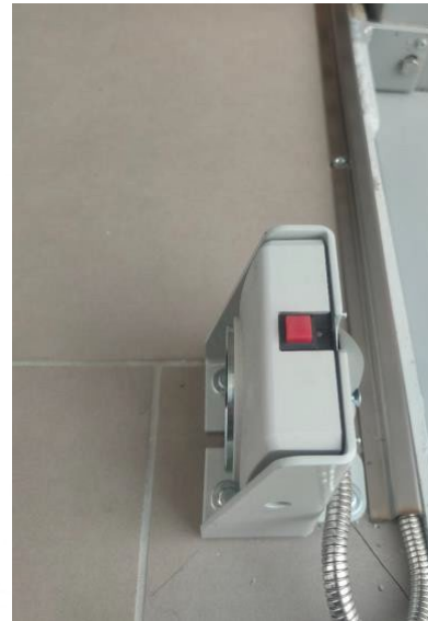
Ejemplo de retenedor electromagnético instalado en suelo.
