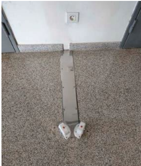
Ejemplo de retenedor electromagnético instalado en suelo.
