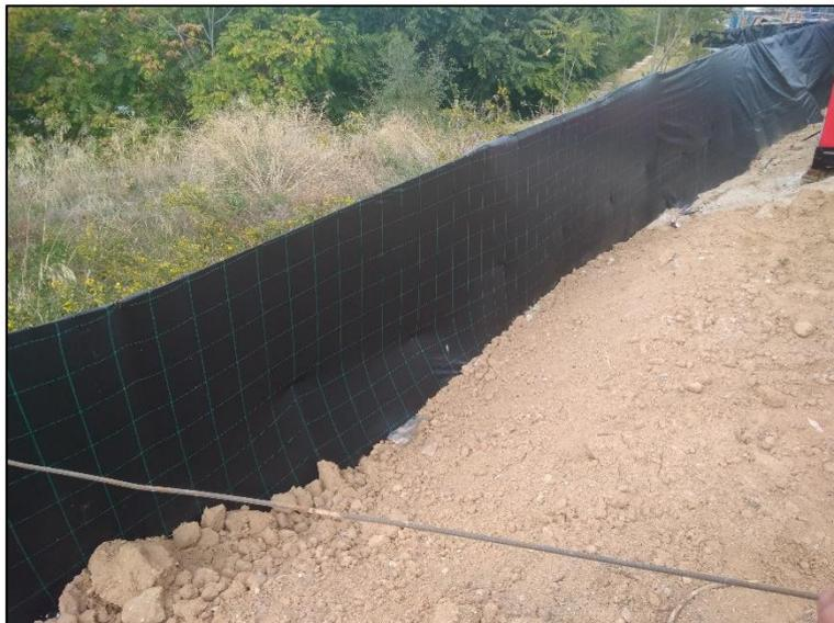
Figura II.2. Trampas de retención de sedimentos, sediment fences, instaladas en una obra de construcción de viviendas.
