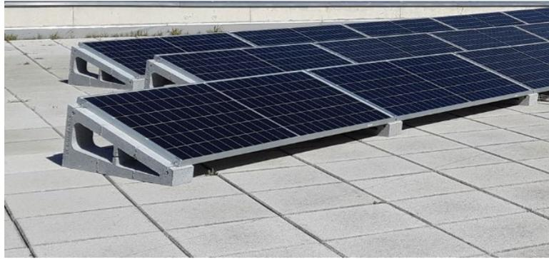
Figura 20. Ejemplo de estructura de agarre de paneles.
